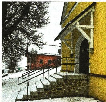
▲ Der neue Treppenaufgang im Schnee: Granit auf Feld- und Bruchsteinmauerwerk.
