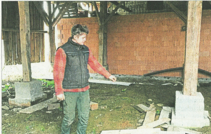
Abrundung: Aus dem Stadl soll ein Veranstaltungsraum mit zwei Flügeltüren werden. Fabian Rohrmüller zeigt erste Vorarbeiten: Unter die Stützpfiler wurden Betonfundamente gesetzt.
