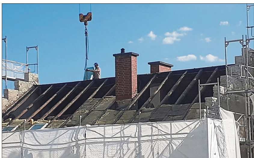
Auch das Dach samt Lattung wurde bei den Bauarbeiten komplett erneuert.
